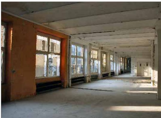
Obergeschoss mit Kappendecken
